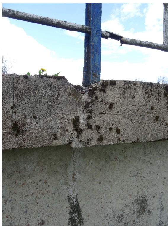
Fot. 8. Balustrada stalowa-korozja i ubytki w elementach balustrady i betonie wspornika
