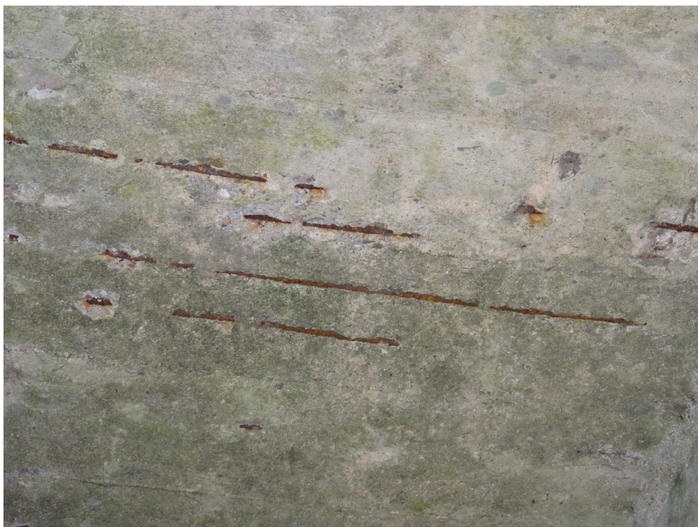
Fot. 22. Spód płyty ustroju niosącego lokalnie odsłonięte zbrojenie, lokalna korozja betonu
