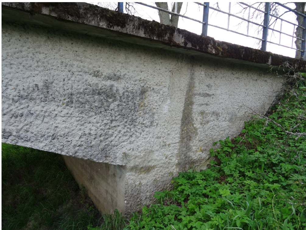
Fot. 13. Widok mostu z boku od strony górnej wody-rysa i zacieki na przyczółku na PM
