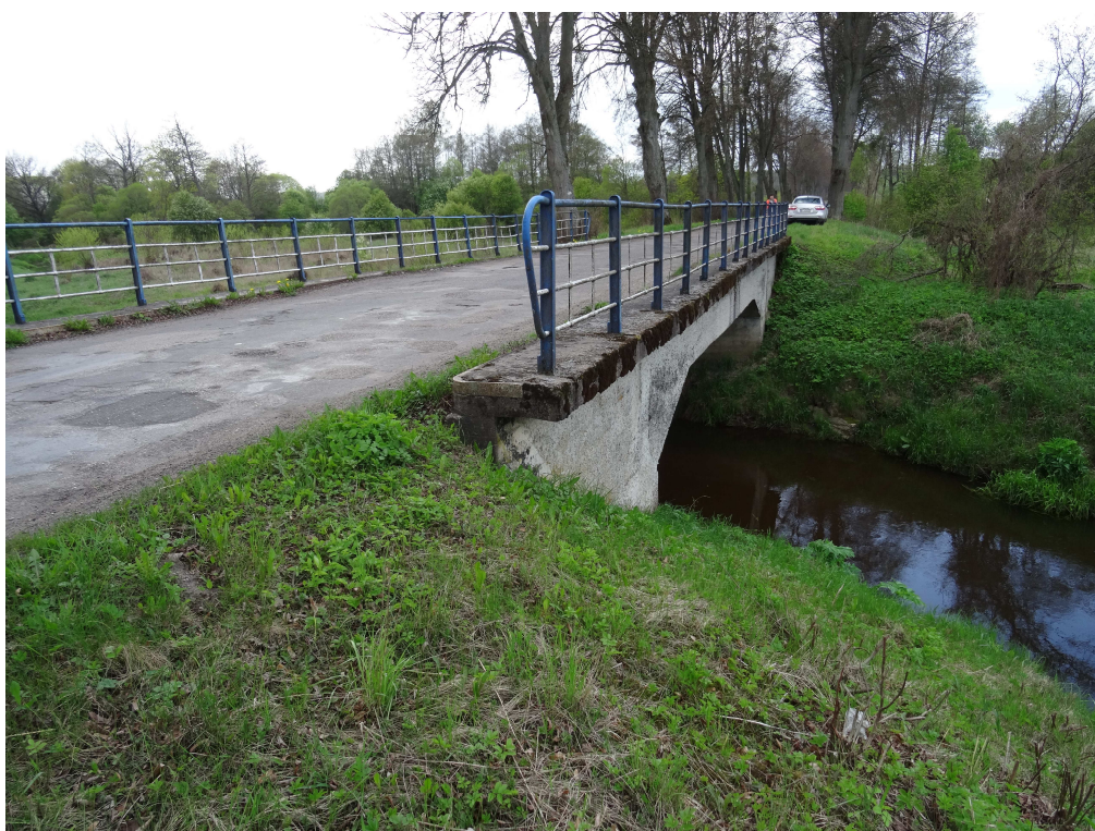
Fot. 6. Widok mostu z boku w kierunku początku mostu- Nierówności i ubytki nawierzchni, ubytki nasypu
