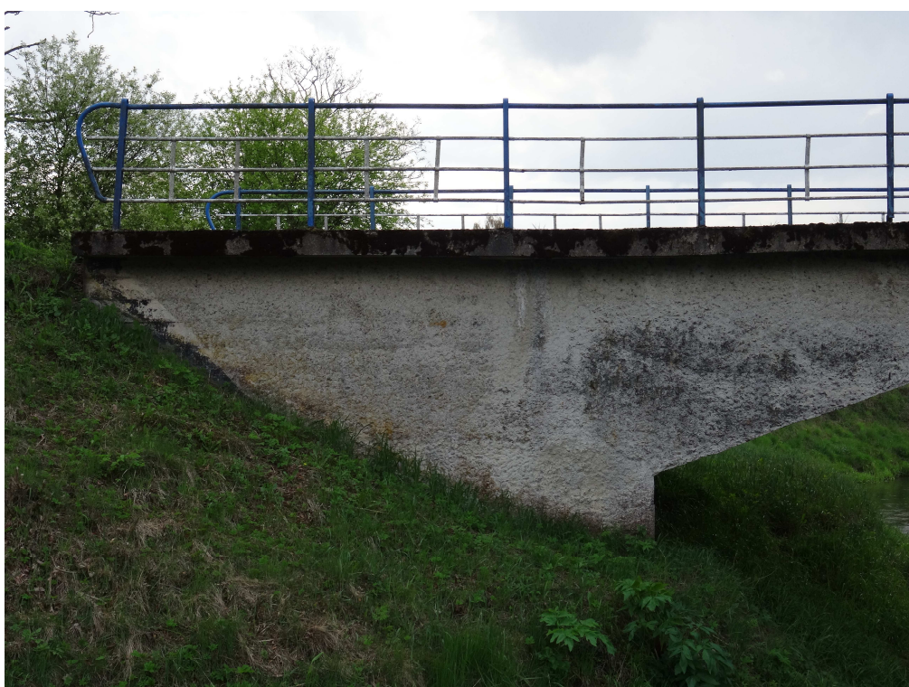
Fot. 14. Widok mostu z boku od strony górnej wody-rysa i zacieki na przyczółku na KM, częściowo odsłonięte skrzydełko
