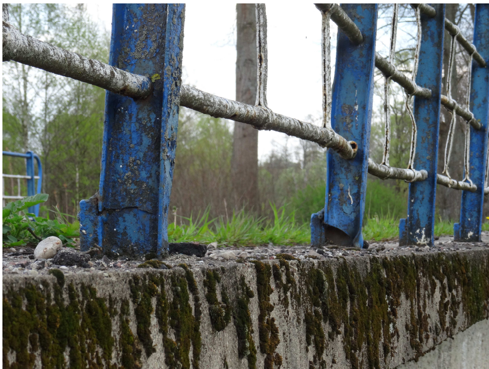
Fot. 7. Balustrada stalowa-korozja i ubytki w elementach balustrady
