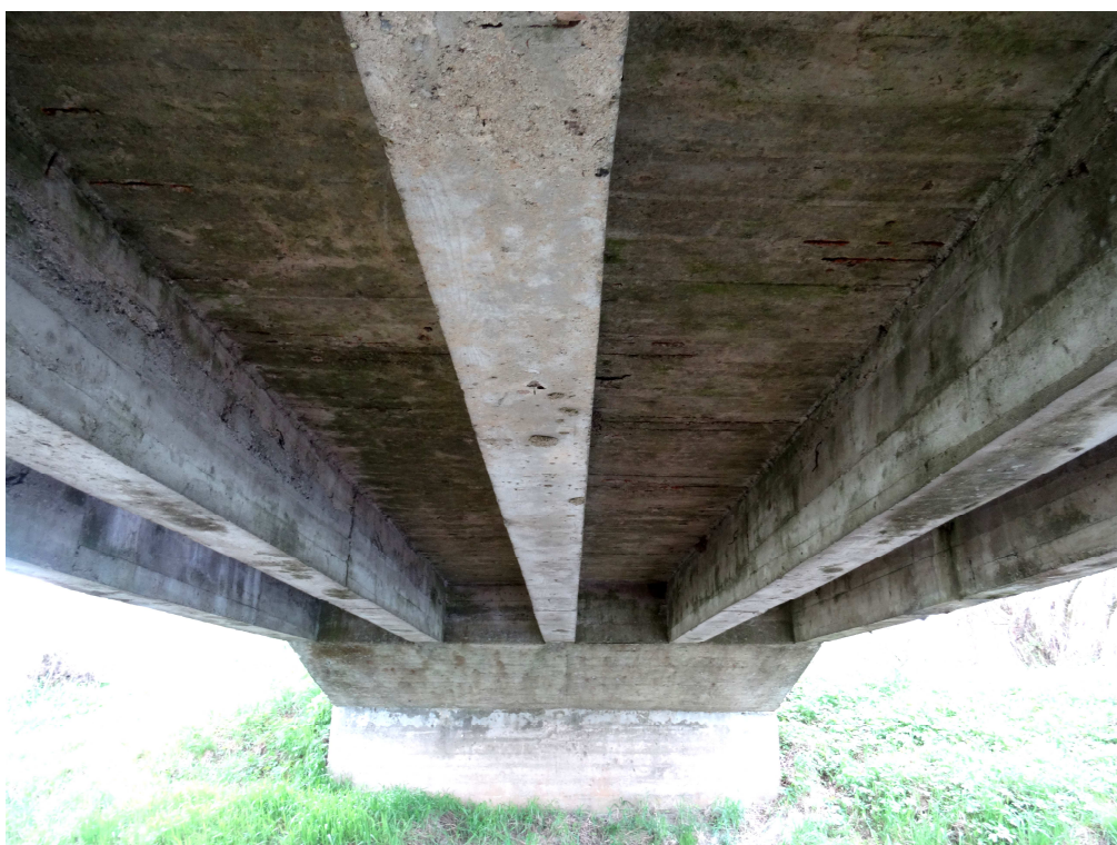
Fot. 10. Spód ustroju niosącego i przyczółek na początku mostu
