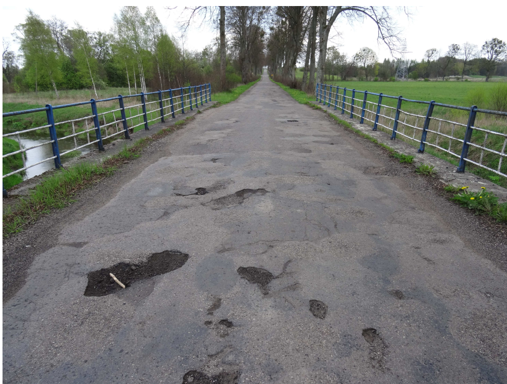
Fot. 4 Widok w kierunku końca mostu- Nierówności i ubytki nawierzchni, korozja i uszkodzenia balustrad
