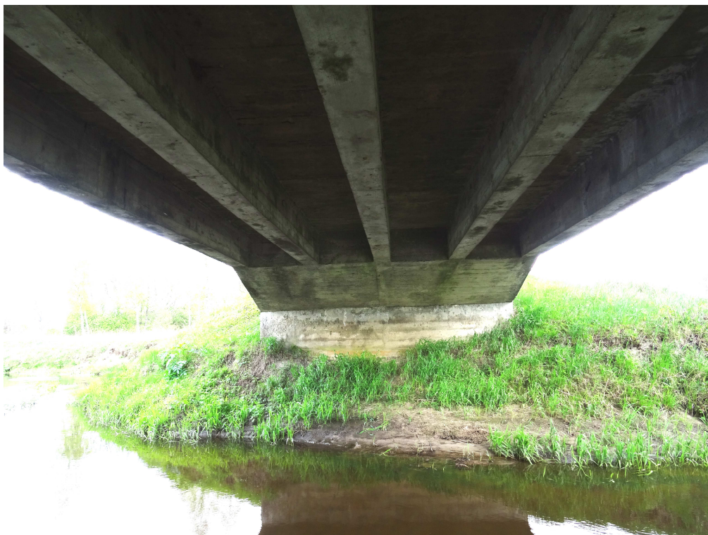
Fot. 9. Spód ustroju niosącego i przyczółek na końcu mostu
