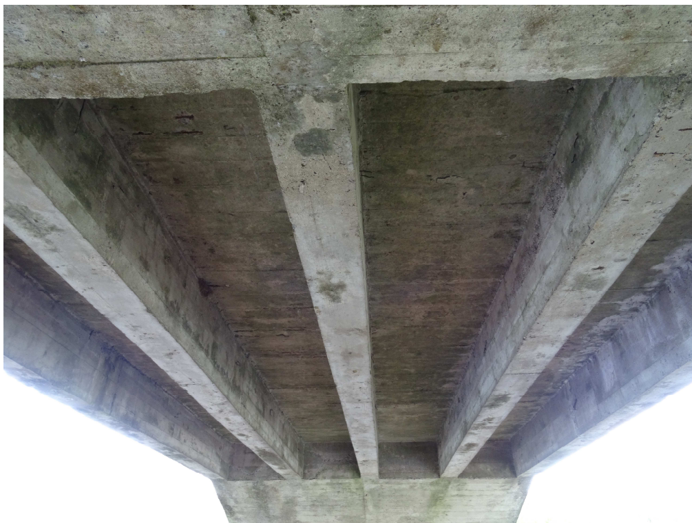
Fot. 17. Spód ustroju niosącego widok w kierunku KM- lokalnie odsłonięte zbrojenie
