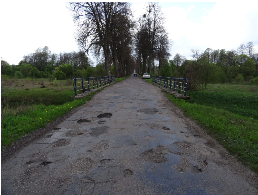
Fot. 5. Widok w kierunku początku mostu- Nierówności i ubytki nawierzchni, korozja i uszkodzenia balustrad
