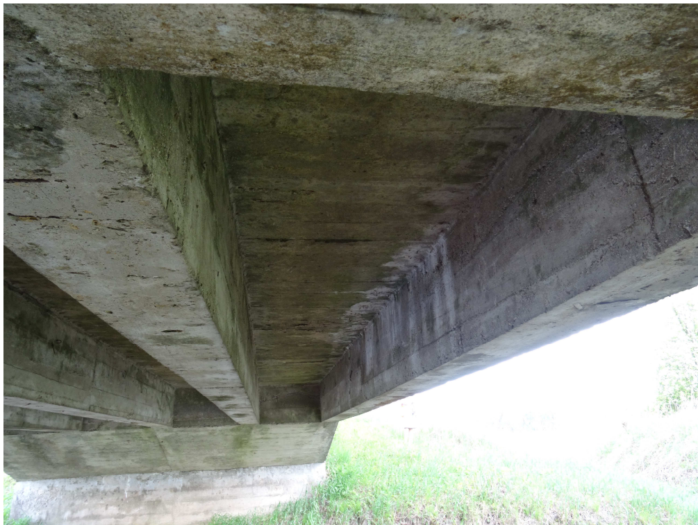
Fot. 18. Spód ustroju niosącego widok w kierunku KM , I pole od dolnej wody- lokalnie odsłonięte zbrojenie, przecieki przez izolację
