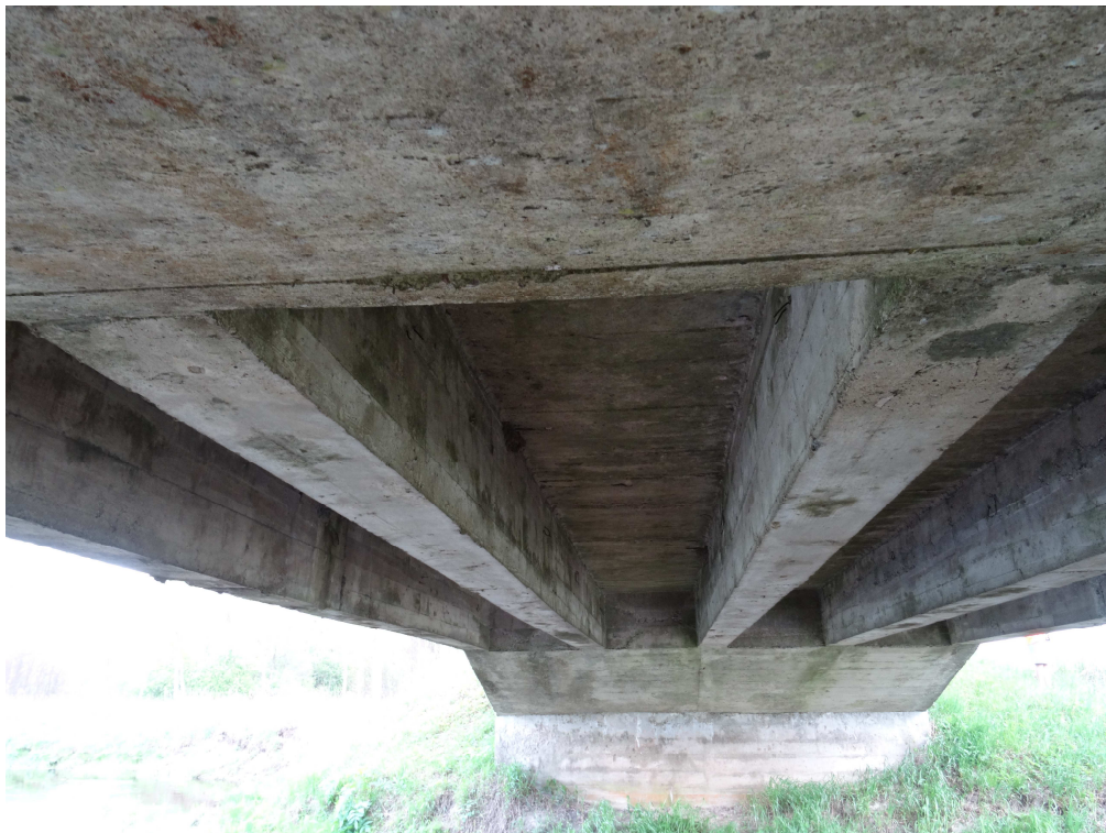
Fot. 20. Spód ustroju niosącego widok w kierunku KM , III pole od dolnej wody- lokalnie odsłonięte zbrojenie, lokalna korozja betonu
