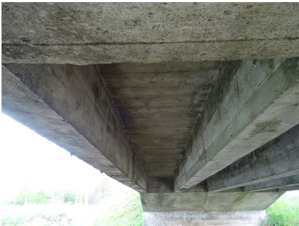
Fot. 21. Spód ustroju niosącego widok w kierunku KM , IV pole od dolnej wody- lokalnie odsłonięte zbrojenie, przecieki przez izolację, lokalna korozja betonu
