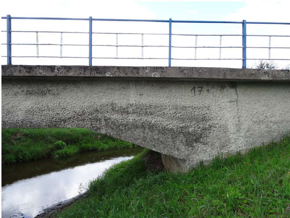
Fot. 16. Widok mostu z boku od strony dolnej wody-rysa i zaciek na przyczółku na KM,
