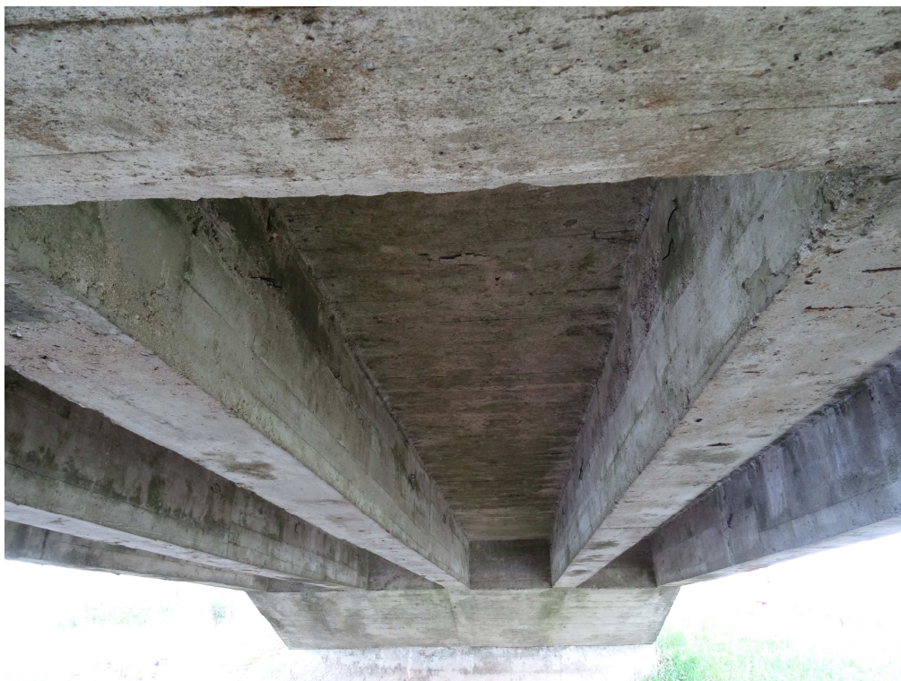
Fot. 19. Spód ustroju niosącego widok w kierunku KM , II pole od dolnej wody- lokalnie odsłonięte zbrojenie, lokalna korozja betonu
