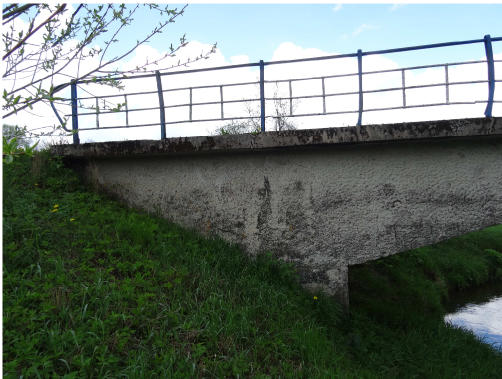
Fot. 15. Widok mostu z boku od strony dolnej wody-rysa i zaciek na przyczółku na PM, widoczne fragmenty odkrytego zbrojenia, częściowo odsłonięte skrzydełko
