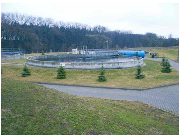
fot. 3 Oczyszczalnia ścieków w Bartoszycach
