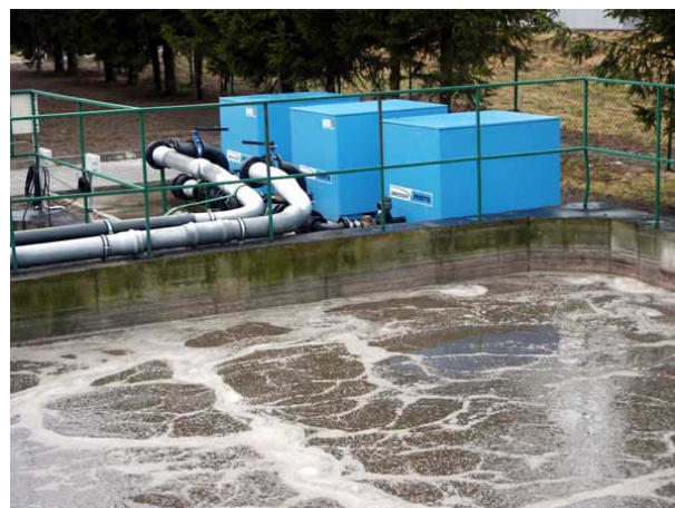
fot. 4 Oczyszczalnia ścieków w Sępopolu
